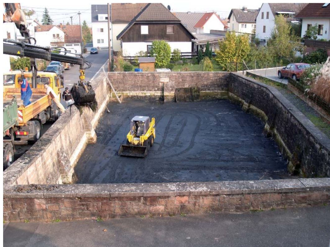
Die letzte gründliche Reinigung des Weihers erfolgte 2007 mit einem kleinen Bagger, der den bei Starkregen angeschwemmten Bodensatz aufnahm.
