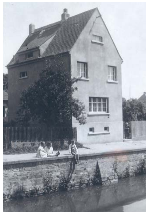
1935 nutzte man den Weiher als Eislauffläche und in 1939 die Sommernutzung, in dem sich die Familienmitglieder in der Freizeit auf den Mauern sonnten, ein TV gab es noch nicht und Urlaub konnten sich viele nicht leisten.
